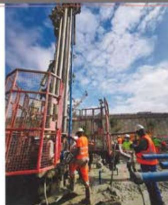
Équipement de forage en tube PVC au travers du tube métallique.
