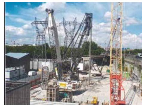
Foreuse à la benne à câbles et Rotoforeuse se mettant en place au droit du forage.
