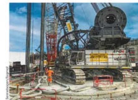
L'un de deux porteurs 6140HD de chez Sennebogen en équipement Rotoforeuse et benne à parois.
