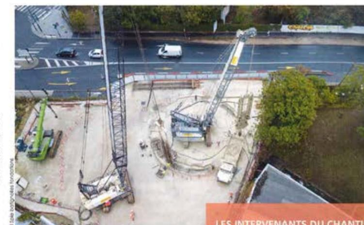
Puits Briche, forage à la benne.
