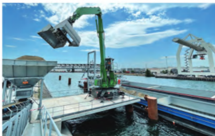
La pelle Sennebogen 840E est implantée au Port Edouard Herriot à Lyon, elle alimente les stocks et les installations de production Pradier.
